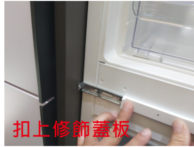
鎖上固定冰箱與側板用的連結五金
