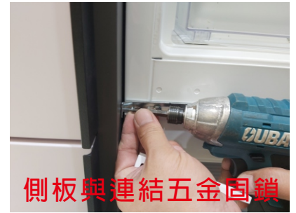
鎖上固定冰箱與側板用的連結五金
