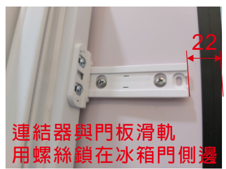
△ 滑軌端面與系統櫃門板邊緣相距22mm
