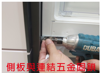
鎖上固定冰箱與側板用的連結五金
